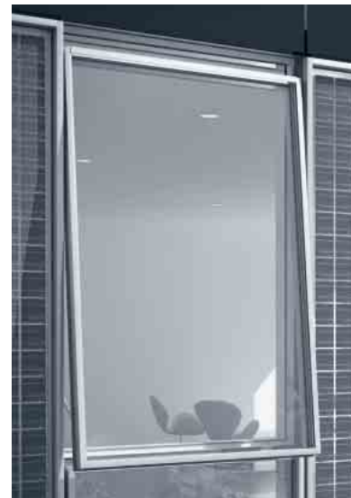
Schüco SFC 85 mit Senkklapp-Fenster Schüco SFC 85 with projected top-hung window
