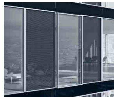
Objektspezifische Solarmodule Project-specific solar modules
