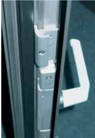
Sicherheits-Verriegelung bei einbruchhemmendem DK-Beschlag WK3 Security locking for burglar-resistant turn/tilt fittings WK3
